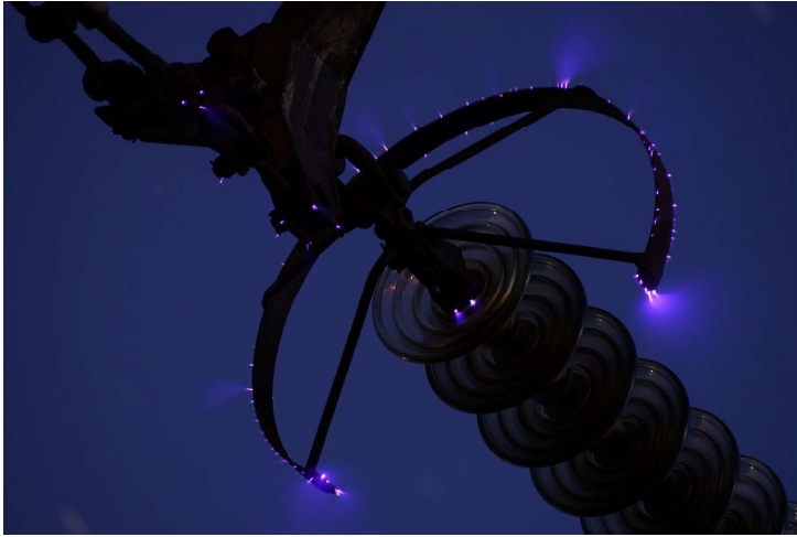
FIG. I.14. Effet de couronne sur un éclateur (ligne de 500 kV); il correspond à une perte en ligne et à une production d'ozone troposphérique polluant. Source : https://fr.wikipedia.org/wiki/Effet_corona
