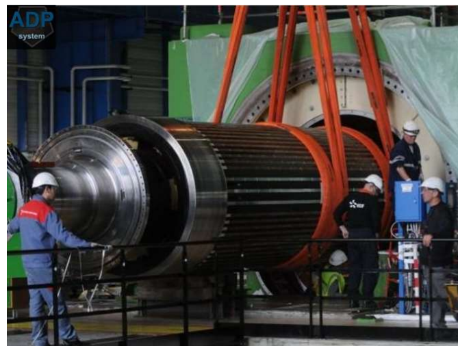
FIG. II.9. Rotor d'une centrale hydroélectrique.
